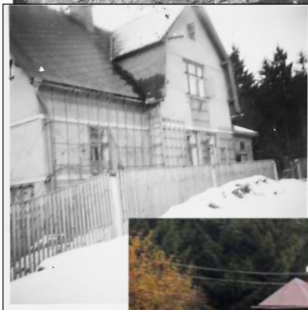
Kopání základů domu čp. 84
