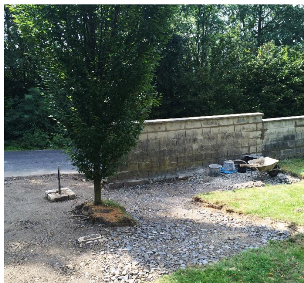
Práce na hřbitovní zdi a bráně pokračují, byl vybagrován základ a zpevněn příjezd do brány a zabetonovány patky pro budoucí novou bránu. Zeď byla nově vyspárována, a kde bylo potřeba opravena.
