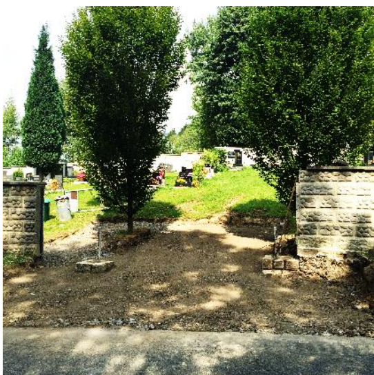
Práce na hřbitovní zdi a bráně pokračují, byl vybagrován základ a zpevněn příjezd do brány a zabetonovány patky pro budoucí novou bránu. Zeď byla nově vyspárována, a kde bylo potřeba opravena.
