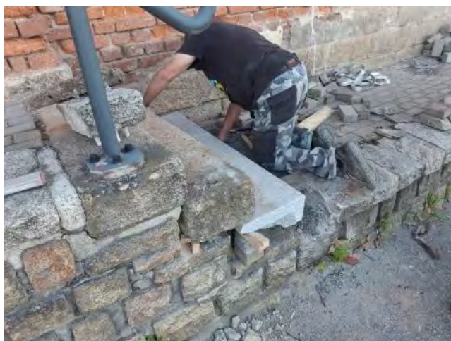
V průběhu prací
