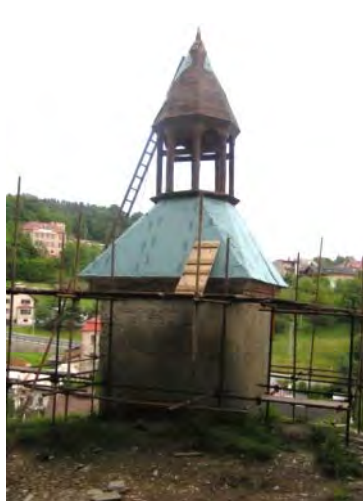
Výměna starých prken a pokrytí izolačním materiálem a krytinou
