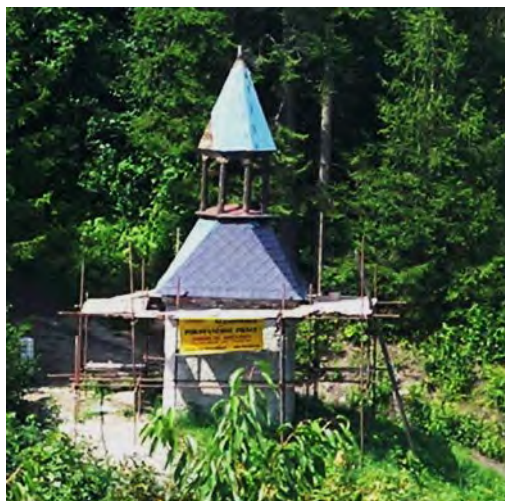
Výměna starých prken a pokrytí izolačním materiálem a krytinou
