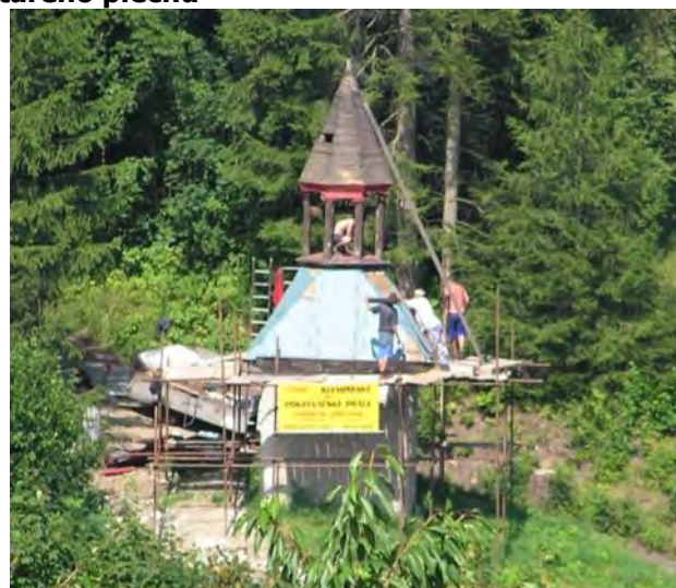
Výměna starých prken a pokrytí izolačním materiálem a krytinou
