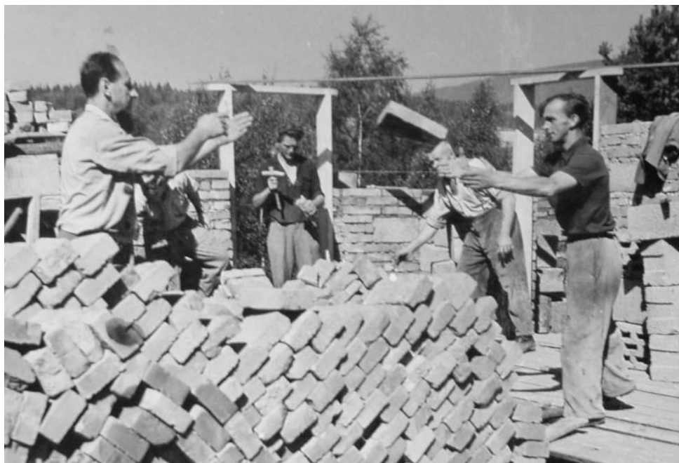
Stavba sokolovny – Kulturní dům – akce „Z“ - Rezler, Bernt, Joh
