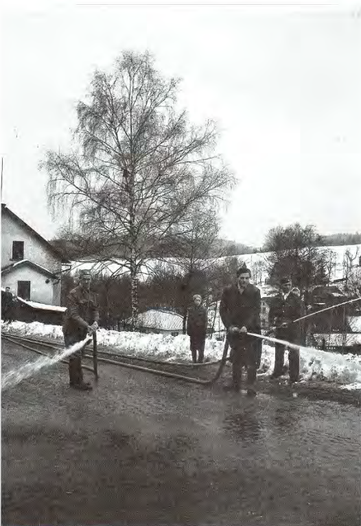
Foto: úklid silnice
