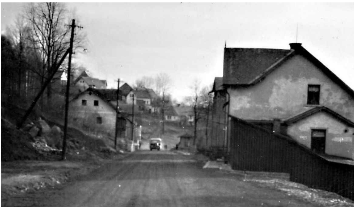
Foto: trafostanice, pohled na hlavní silnici
